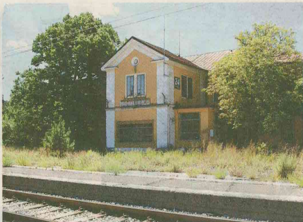
Il vecchio edificio della Stazione di Prosecco a Sgonico: verrà rivoluzionata la viabilità di tutta l'area circostante
