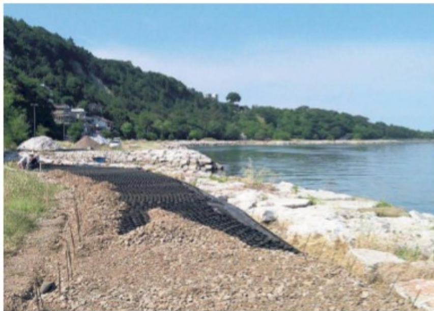
L'area del terrapieno Acquario a Muggia
